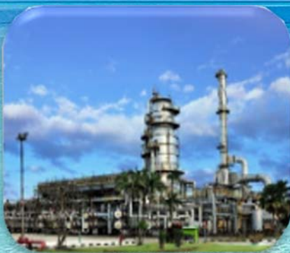
Project Desalter Pertamina RU III Plaju
